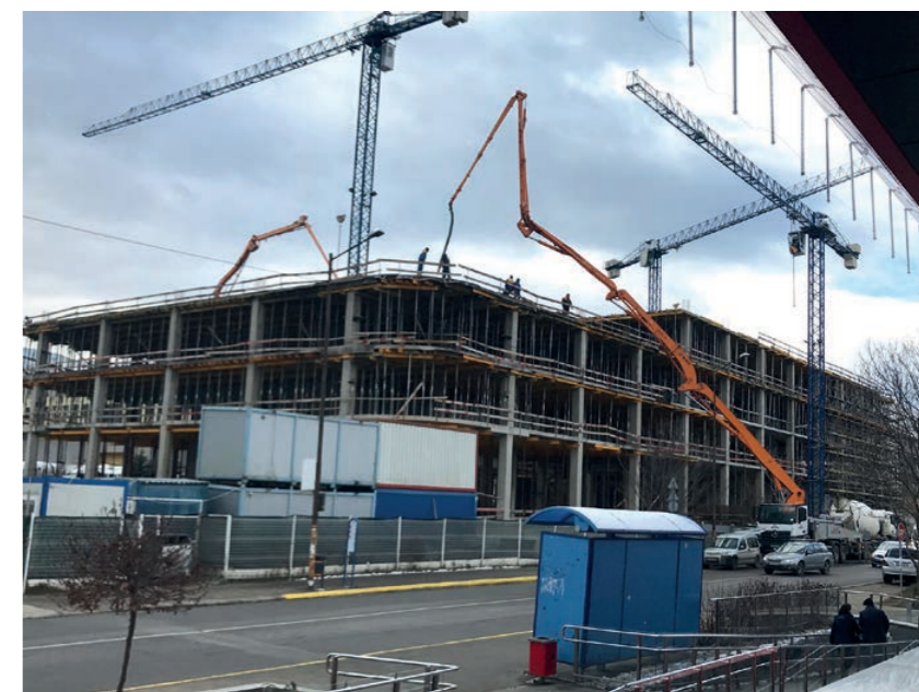
Бетон-помпи CIFA участват в изпълнението на знакови строителни обекти в София
