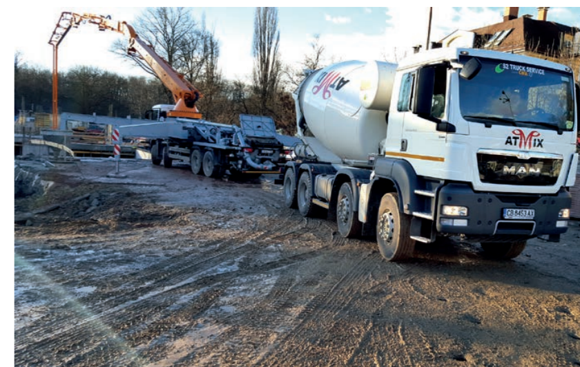
Бетон-помпа и бетоновоз CIFA в действие – перфектният тандем
