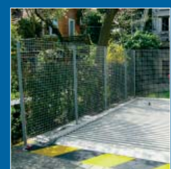
marking pit edge
