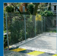
marking pit edge
